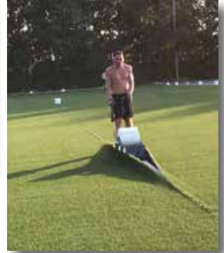
Eine zusätzliche Klebung, damit sich die Nähte nicht lösen
