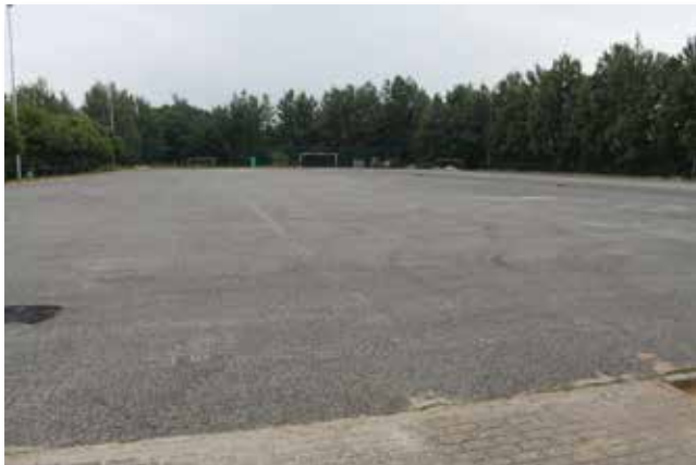
Der komplett abgeschälte Platz wartet auf den neuen Rasen
