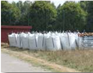
In diesen Säcken befinden sich 30 Tonnen EPM-Granulat, welches in Verbindung mit dem Sand für den Untergrund sorgt.
