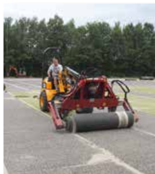
Danach werden die Bahnen maschinell aufgewickelt. Jede Rolle wiegt mit dem alten Sandbelag ca. 1 Tonne
