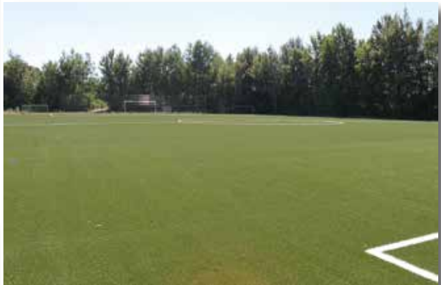
Fertig. Jetzt muss es nur noch regnen, damit sich Quarzsand und Granulat gut vermischen und etwas verfestigen.
