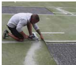
Mit einem speziellen Messer werden Bahnen geschnitten
