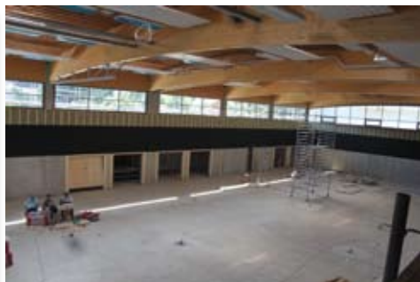
Die große Halle von der Balustrade aus. Die Türen der Geräteräume sind schon montiert.
