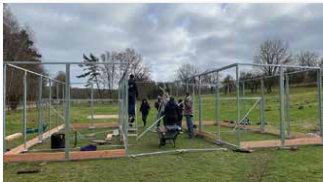
Stall im Rohbau
