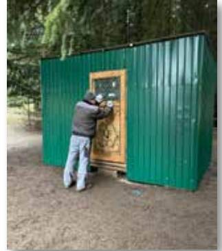
Sattelkammer Aufbau - fertig
