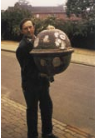
Die Elstorfer Kirchturmspitze vor der Reparatur
